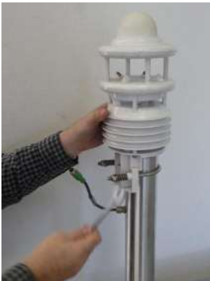
Abbildung 9: Anbringen der Wetterstation am Rohr
