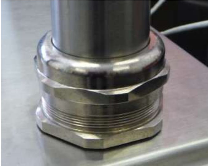
Abbildung 8: Fixierung des Wetterstationrohres
